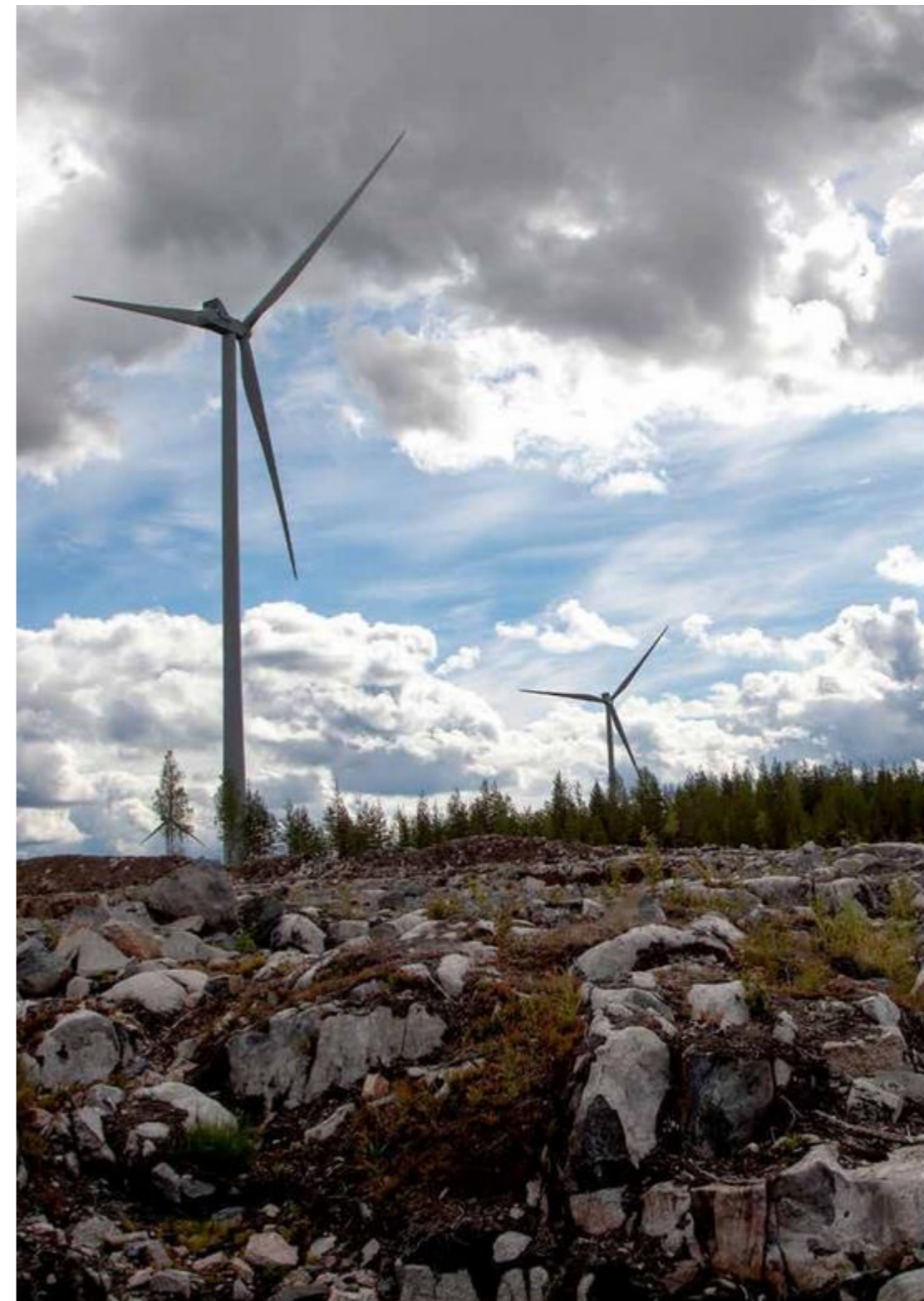
Exemple d'éolienne VESTAS correspondant au gabarit envisagé (source : VESTAS)
