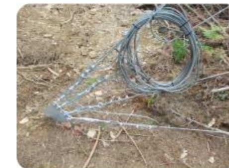
Ancrage des haubans au sol
